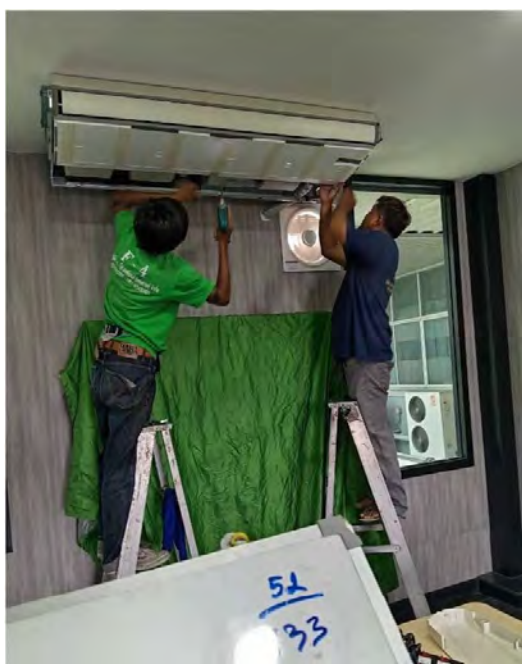
ภาพที่ 1 ทำความสะอาดเครื่องปรับอากาศ
