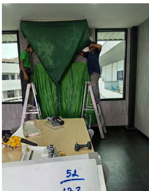
ภาพที่ 1 ทำความสะอาดเครื่องปรับอากาศ
